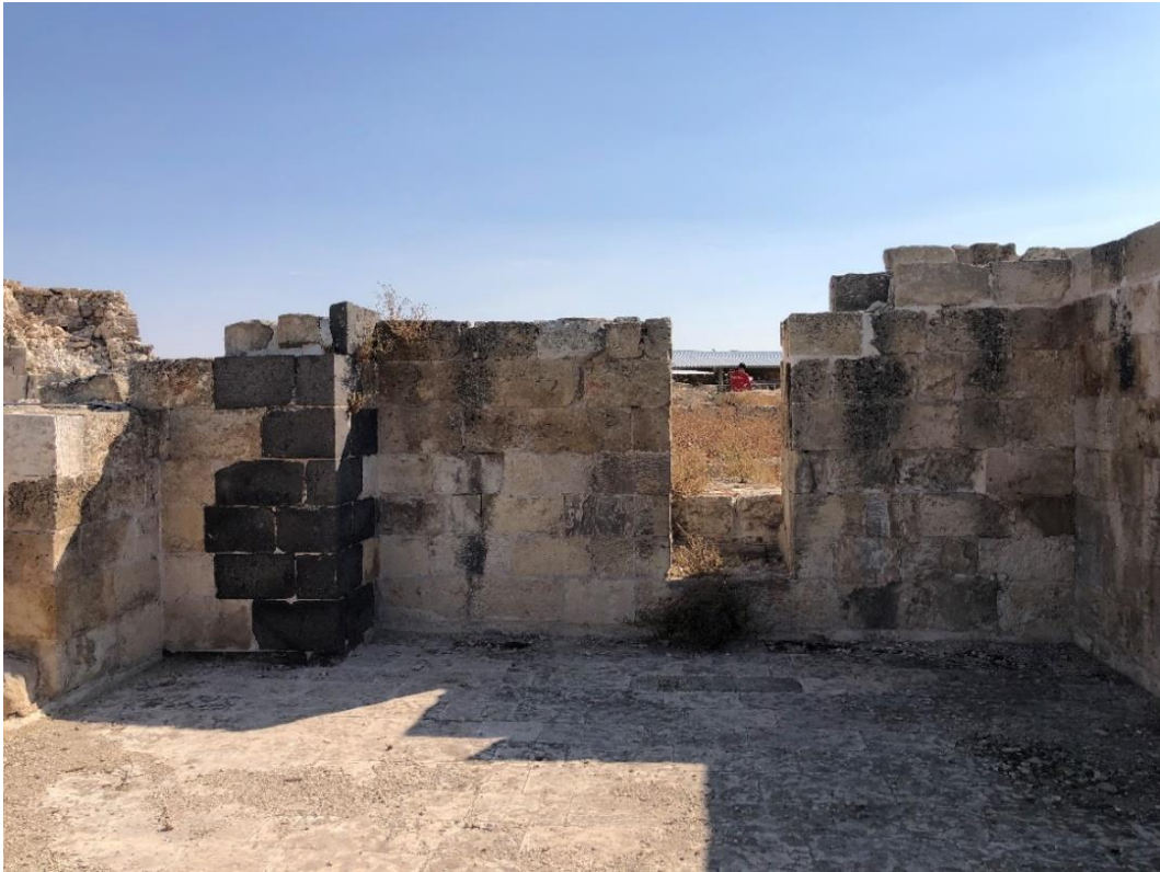
Görsel-22: Harimin Doğu Duvarında Bulunan Minareye Geçiş Kapısı
