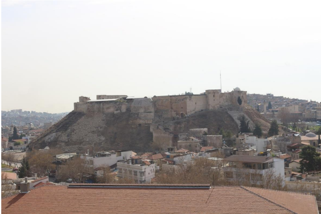
Görsel-6: Gaziantep Kalesi Kuzey Batı Cepheden 06.02.2023 Depremi Sonrası Durumu
