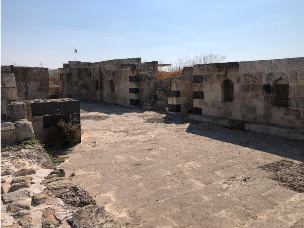
Görsel-26: Harim Batı ve Güney Duvarı
